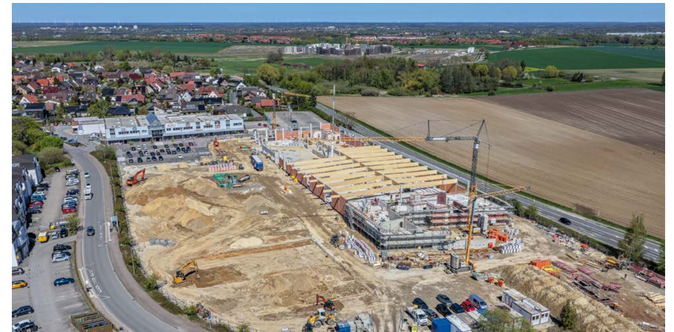
Errichtung MARKTKAUF in Nordsteimke © WMG Wolfsburg, Foto: Drone Fever Wolfsburg
